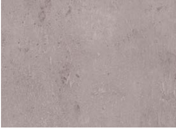
Hormigón Concrete Béton S-806
